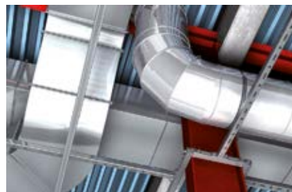
Опорные конструкции для крепления вентиляции
