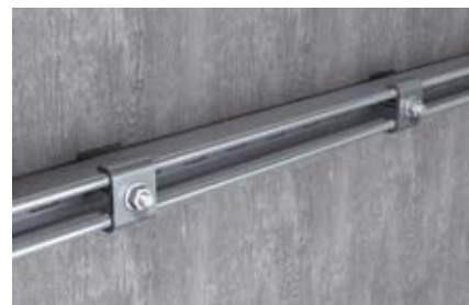
Монтаж шин к стене
