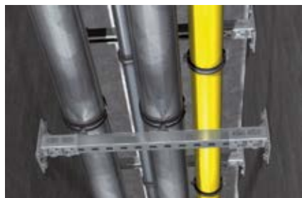
Крепление трубопроводов
