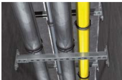
Крепление трубопроводов
