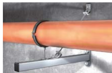
Крепление тяжелого трубопровода на консоль
