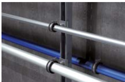
Монтаж поперечных труб к шинам
