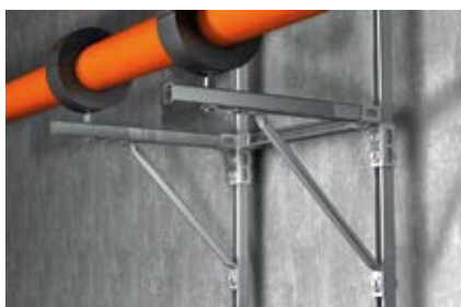
Усиление монтажной шины
